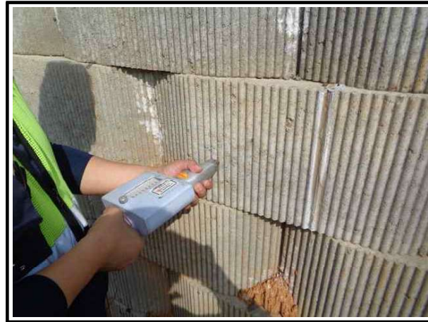
【그림 6.3.6】 슈미트해머를 이용한 반발경도시험 전경
